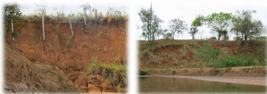
Figura 16. Margem solapada por processo erosivo e intensa sedimentação.
