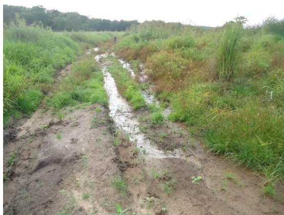
Figura 11. Afloramento das águas do lençol freático no Basalto. Fonte: Paiva, 2015.
