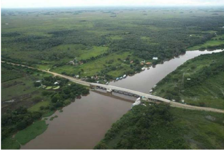
Figura 39. Estrada Parque Pantanal na região do Passo do Lontra - ponte sobre o rio Miranda.
