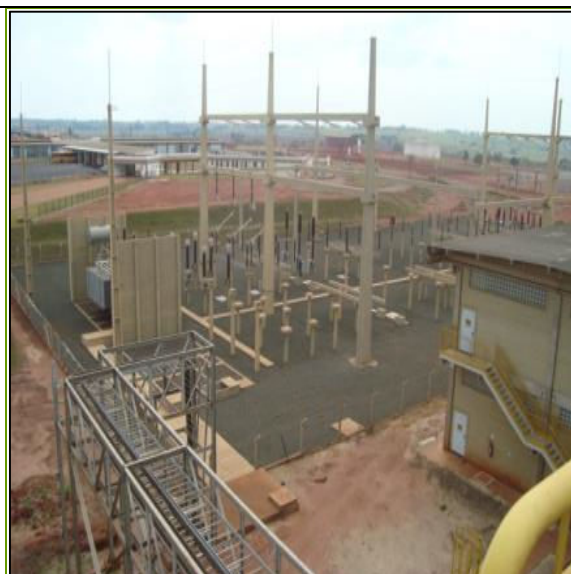
Figura 20 - Subestação de Energia Elétrica para consumo próprio e exportação, dentro das normas técnicas de segurança e controle ambiental.
