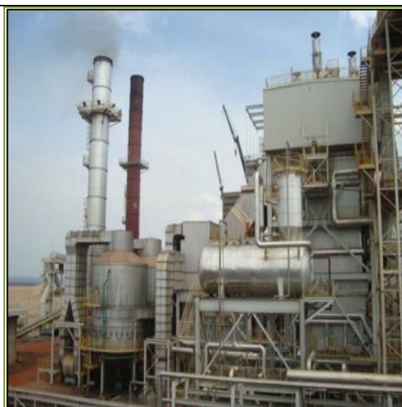
Figura 18 - Setor das caldeiras e sistema lavador de gases modernos e eficientes.
