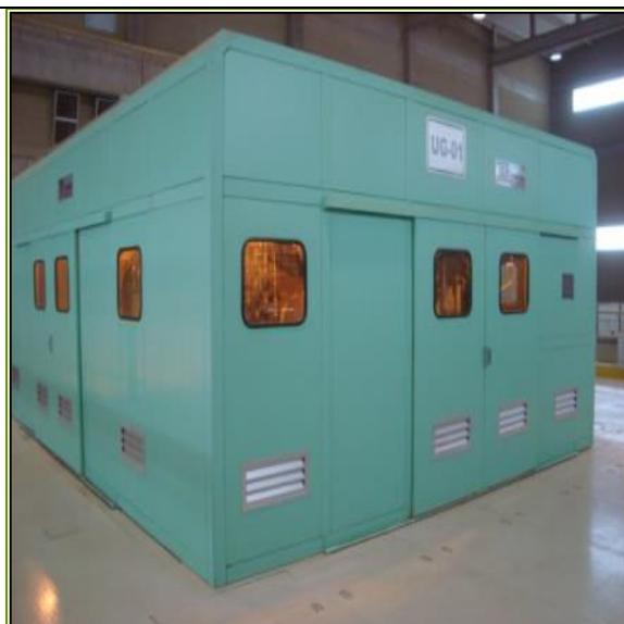
Figura 19 - casa das Turbinas coogerasoras de Energia Elétrica com painéis de comando automatizadas e em local limpo e com controle da temperatura.
