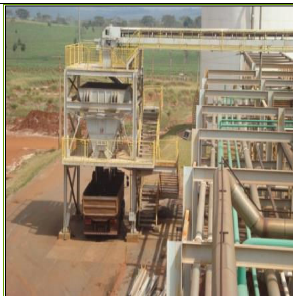
Figura 6 - Carregamento de Torta de filtro para compostagem.
