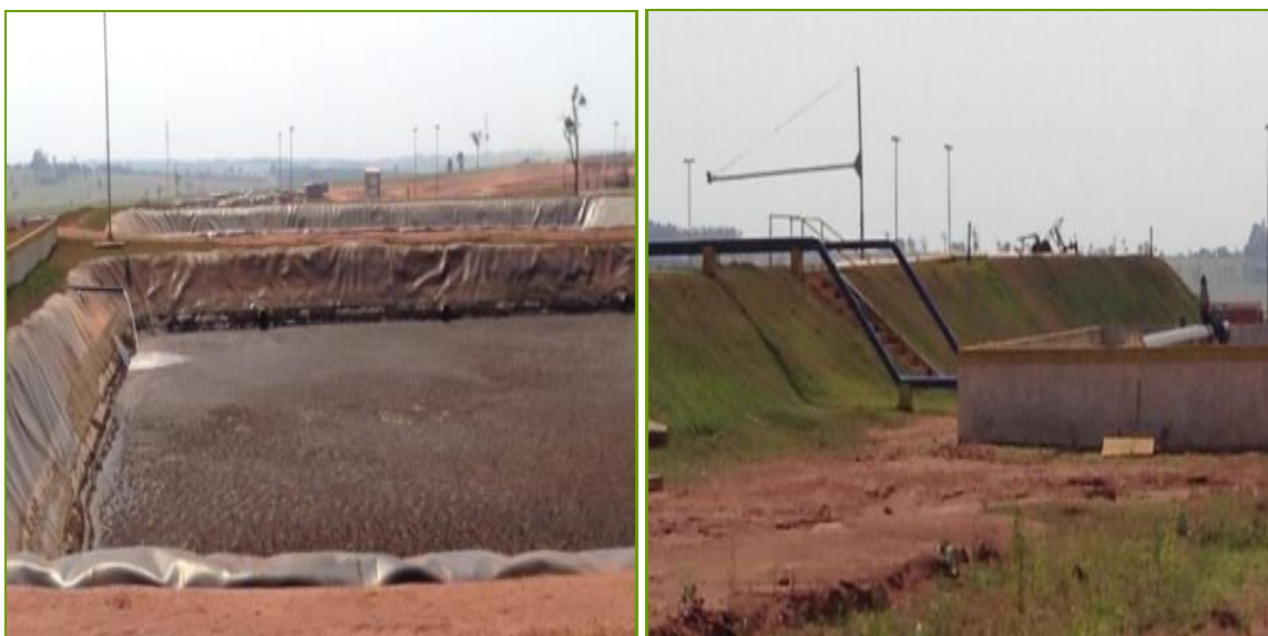
Figura 24 – Fotos dos Tanques de vinhaça existentes, revestidos com PEAD e sistema de drenagem e captação por conjuntos de moto bombas elétricas para o sistema de vinhaça. Golin, I., 2014.
