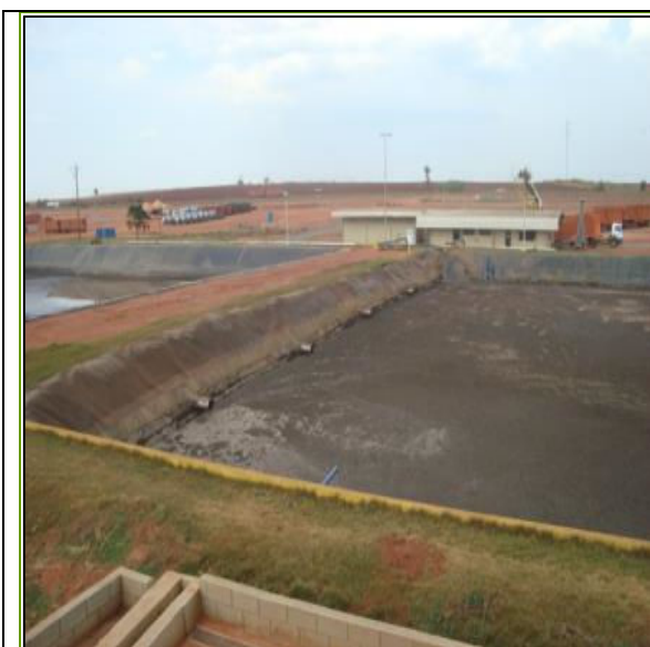
Figura 9 - Tanques de armazenamento de vinhaça desidratada para posterior aplicação nas áreas agrícolas – soqueira da cana.
