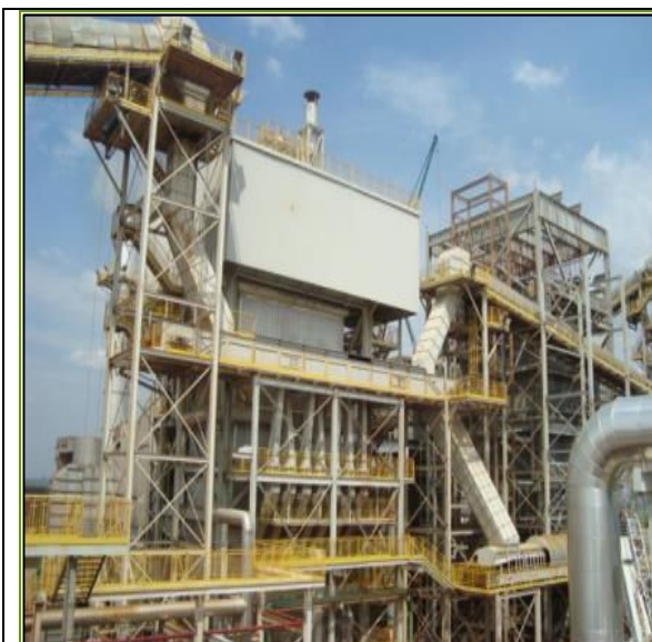
Figura 17 - Caldeira de biomassa utilizada na cogeração de vapor.
