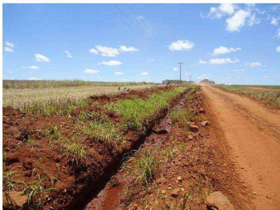
**Figura 13.** Fotografia ilustrando o afloramento de água freática em corte de estrada, localizado na AI, a Sudoeste do Empreendimento. Fonte: Paiva, 2016.
