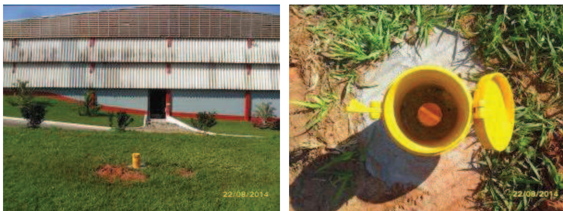
Figura 10. Fotografias ilustrando Poço piezométrico. Fonte: Samorano Consultoria Ambiental, 2014.
