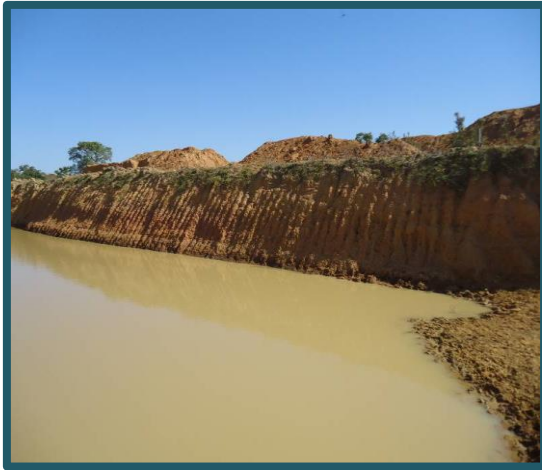
Figura 10.16 – Exposição de material de escavação de acudo constituído por material siltoso.
