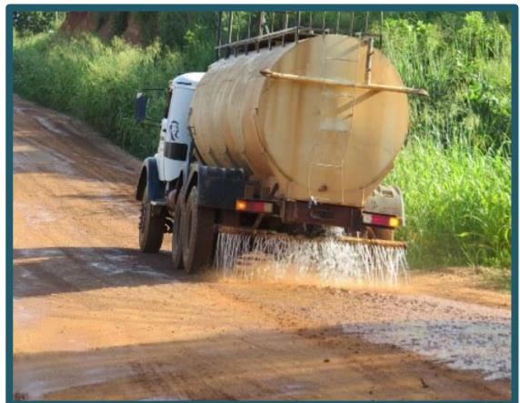
Figura 5.3 – Umidificação das frentes de trabalho.
