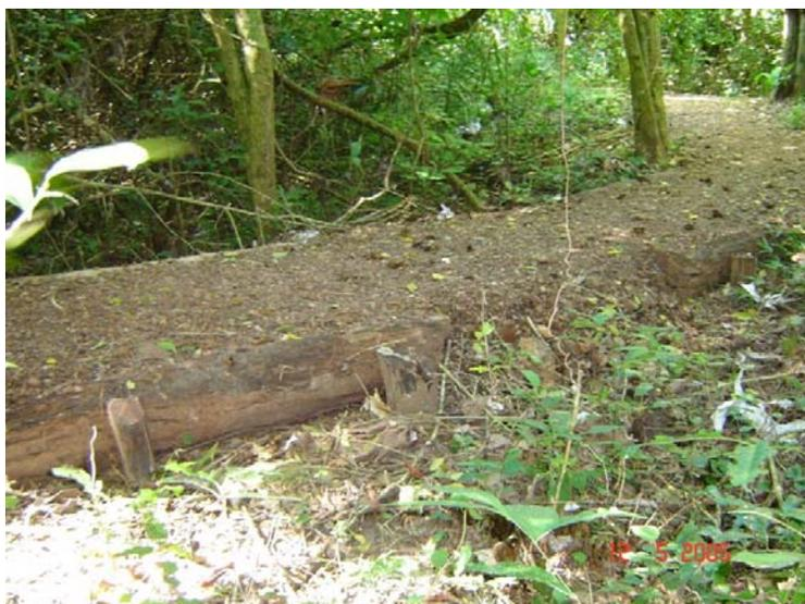
**Figura 95.** Estrutura de levantamento da trilha em local alagado, com drenagem composta de pedras e cano de PVC. Foto: Sandro M. Scheffler.
