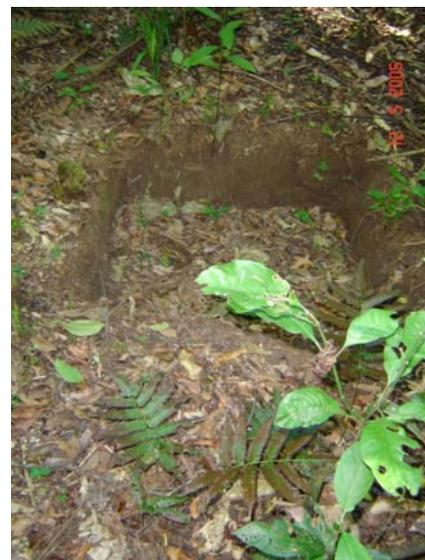
**Figura 96.** Caixa de drenagem ao lado da trilha. Foto: Sandro M. Scheffler.
