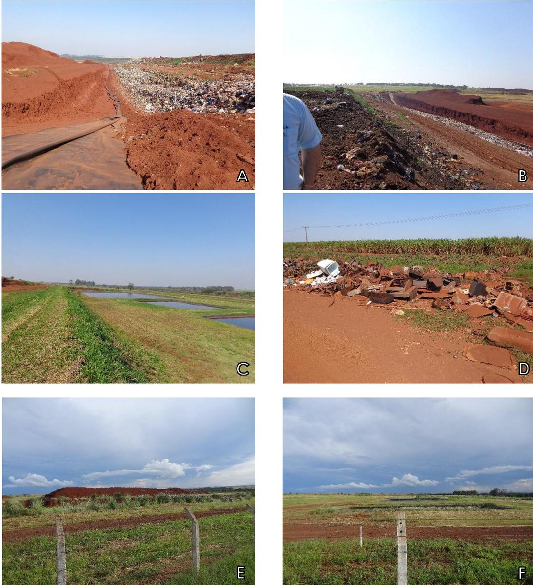
Figura 31 - (A e B) Células de disposição final de Resíduos Sólidos Domiciliares do Aterro Sanitário Municipal; (C) Lagoas do sistema de tratamento do chorume onde é feita a recirculação do efluente; (D) Disposição irregular de Resíduos da Construção Civil e outros ao longo da MS - 156 e (E e F) Vista do Aterro Particular da Financial que se encontra em processo de obtenção da Licença de Operação.
