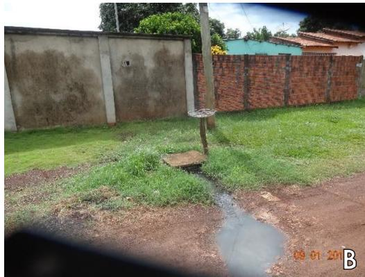
**Figura 27 - Lançamentos clandestinos de esgoto doméstico: na rede pluvial (A); em logradouro público (B); verificado durante o levantamento de campo no município de Dourados, MS.**
