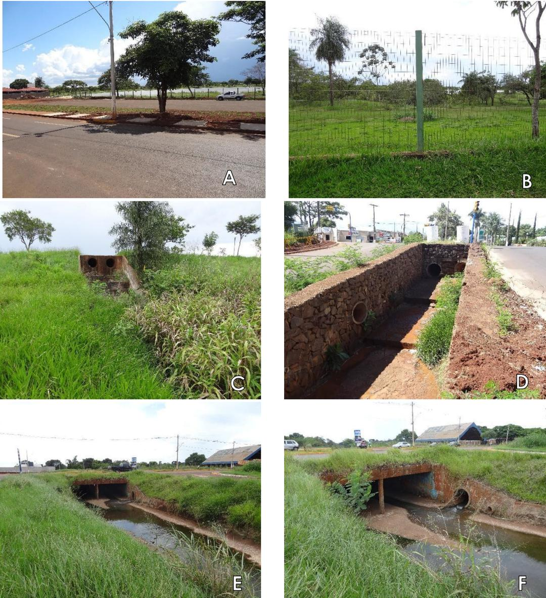
**Figura 18 – Região de cabeceira do Córrego Água Boa referente ao Parque Antenor Martins, onde: (A) vista do lago; (B) perspectiva externa da vegetação existente no Parque; (C) vertedouro da água excedente do lago; (D) impermeabilizado à esquerda do Parque Antenor Martins, na Rua Aziz Rasseler; e (E e F) continuação do canal impermeabilizado “D” após recebimento das águas do lago (vertedor “C”).**
