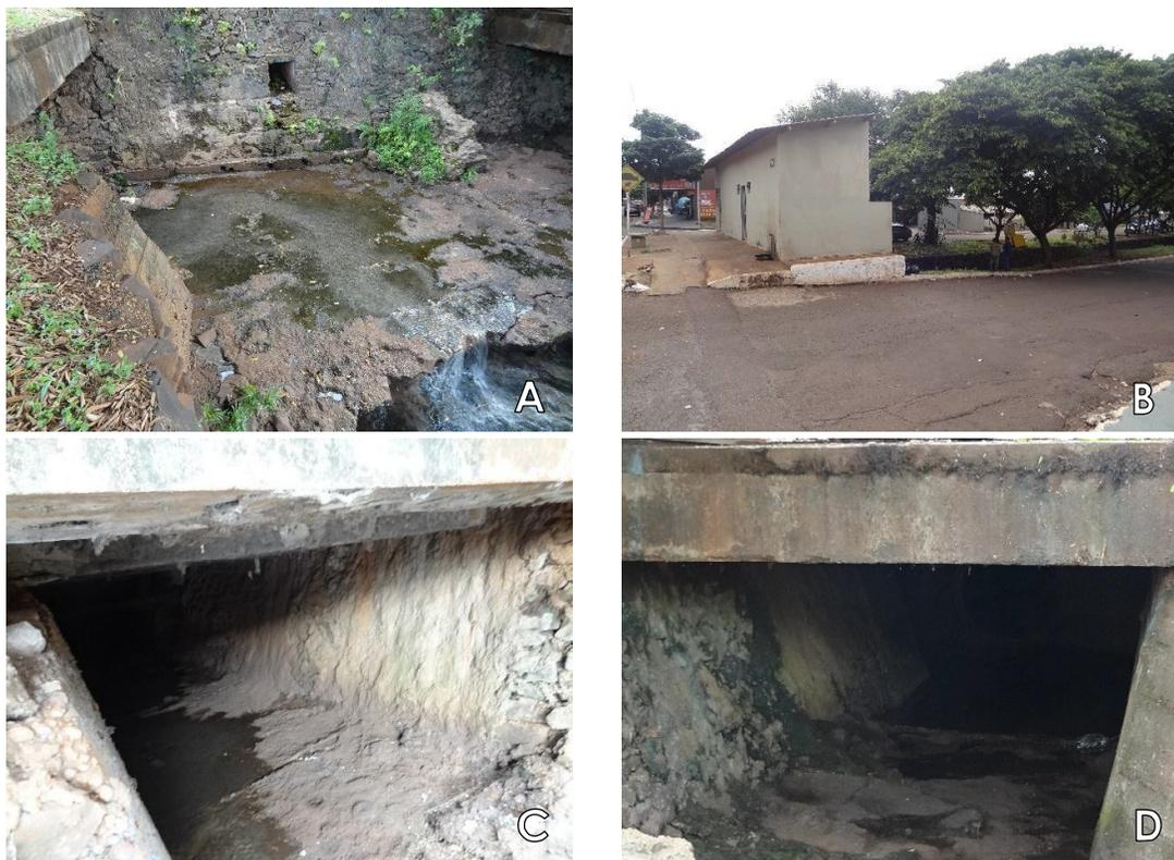
**Figura 17 – Nascente canalizada do Córrego Rêgo d'Água, onde: (A) provável dreno da nascente; (B) banheiro público sobre a nascente canalizada; (C e D) galeria de águas pluviais às margens do canal impermeabilizado do Córrego Rêgo d'Água.**
