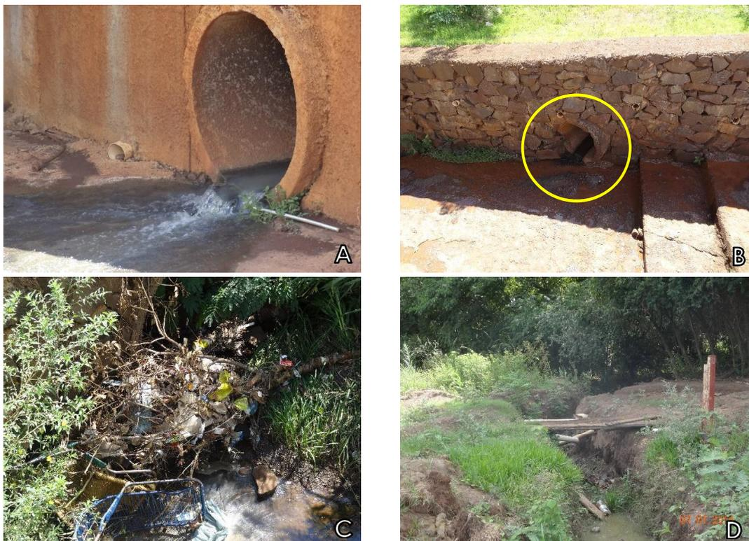
Figura 34 – Ocorrência de lançamentos clandestino de esgoto doméstico (A e B); disposição de resíduos sólidos (C); e canais de drenagem que contribuem com o carregamento de sedimentos para a rede de drenagem pluvial (D).
