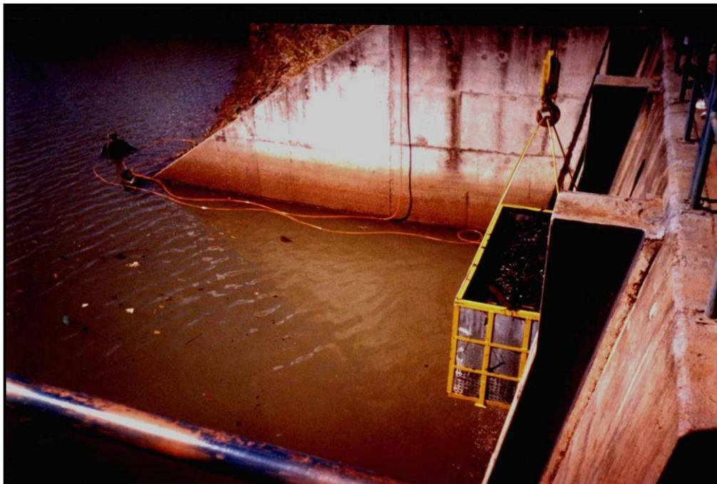
**Foto 43** – Equipe de mergulhadores executando a limpeza - Fonte: NT ENERSUL
