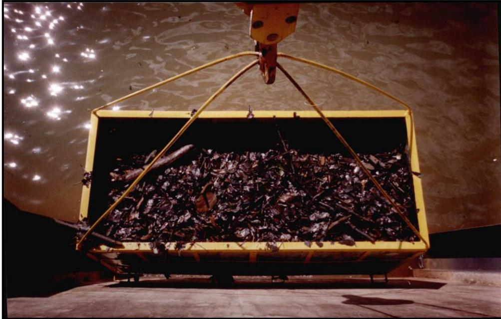
**Foto 44** – Retirada dos detritos em dispositivo próprio - Fonte: NT ENERSUL.
