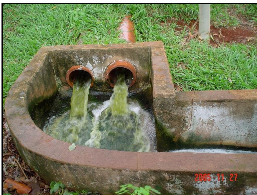
**Foto 57 - Ponto de Descarga do Esgoto da Estação de Tratamento de Esgoto – situada no ponto de coordenadas UTM 274468,0463; 7947559,5650 – Área do reservatório.**
