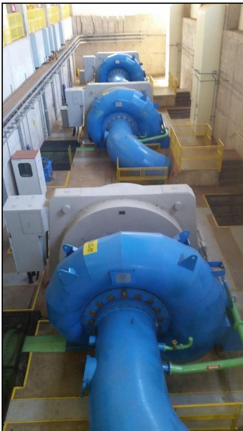
**Foto17 – Vista das turbinas no interior da casa de força.**
