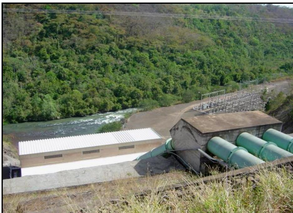
**Foto 12 -Vista dos Conduitos Forçados, Casa de Força, subestação e confluência do rio Sucuriú com o canal de adução.**
