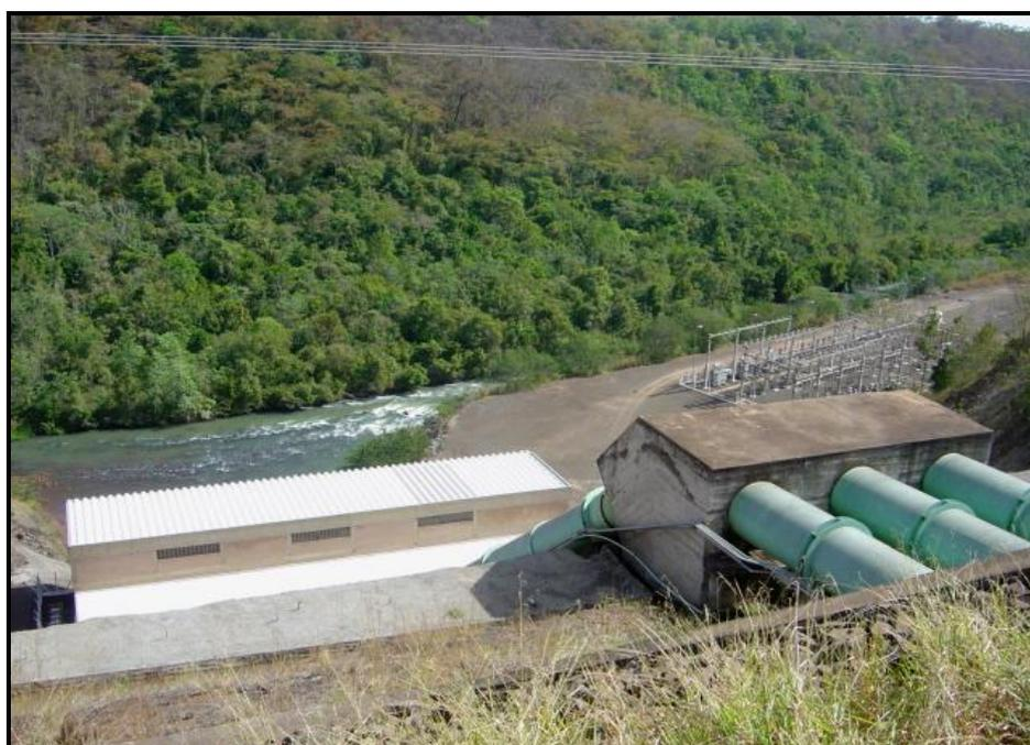
**Foto 16 -Vista dos Conduitos Forçados, Casa de Força, subestação e confluência do rio Sucuriú com o canal de adução.**
