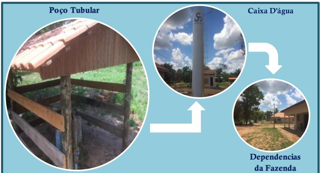
**Figura 10.2 – Poço Tubular da sede da propriedade que alimenta um reservatório (tipo torre) o qual distribui para as dependências da Fazenda.**
