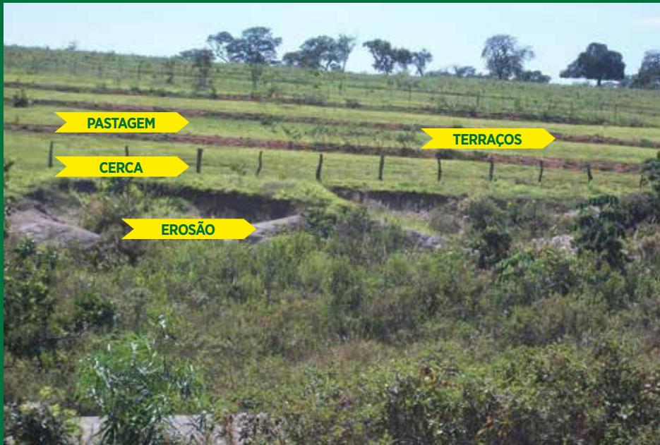
Figura 40: Erosão isolada com cerca de arame.
