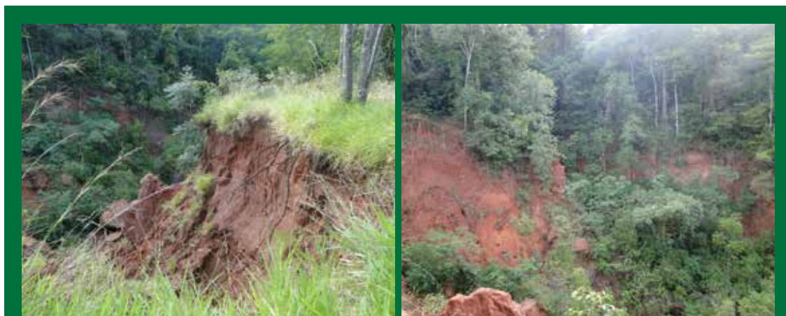
Figura 17: Áreas de Reserva Legal com Processos Erosivos em Estágio Avançado.
