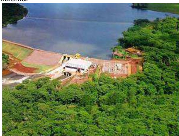
Figura 11 - Vista da área da construção da PCH Porto das Pedras. 2010. Fonte: Atiaia S/A
