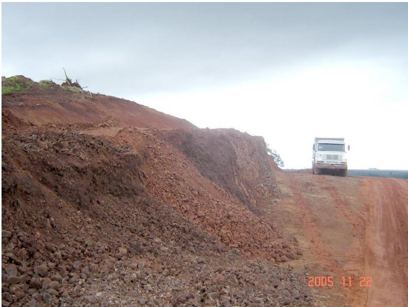
Foto 02 – Aspectos gerais da presença de rocha basáltica na área, sempre ocorrendo de forma alterada e/ou semi alterada.
