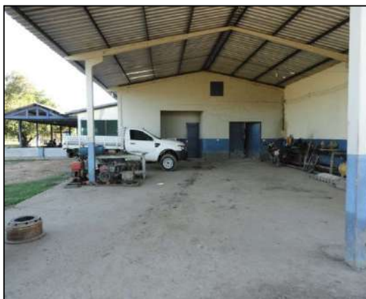
Figura 27 - Área de armazenamento de maquinários, pequenas manutenções e lubrificação no Retiro Velho. Fonte: ARATER, 2018.
