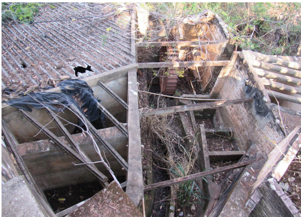
Figura 2.3: Estruturas da antiga casa de força.
