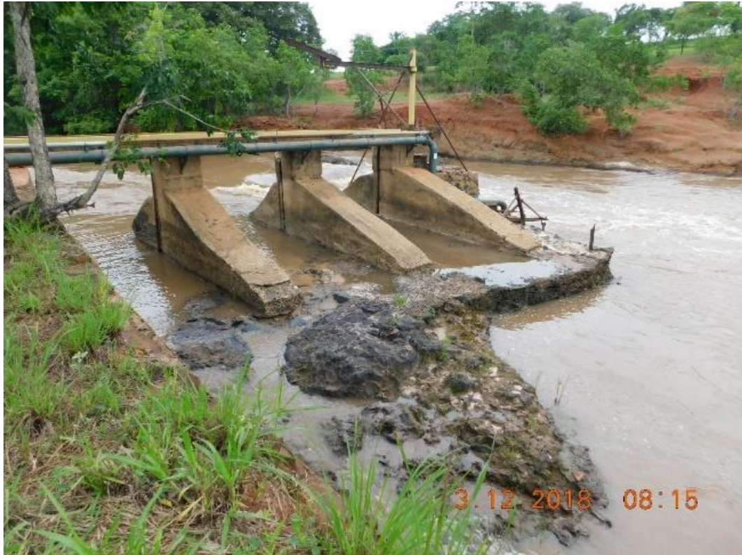
Figura 9.12: Rocha basáltica maciça aflorante no leito do rio no ponto de captação de água superficial da ETA da Sanesul.
