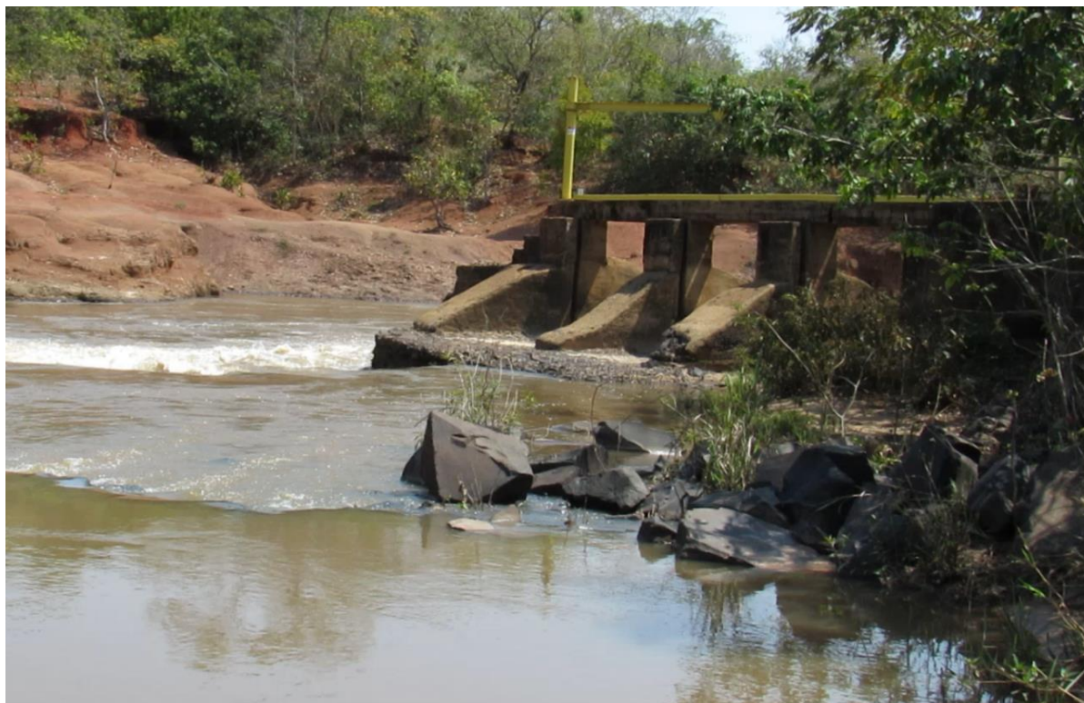
Figura 2.2: Estruturas existentes do antigo Barramento.
