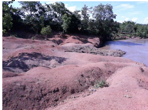
Figura 12.4: Situação atual da Área Degradada a Jusante do Barramento.
