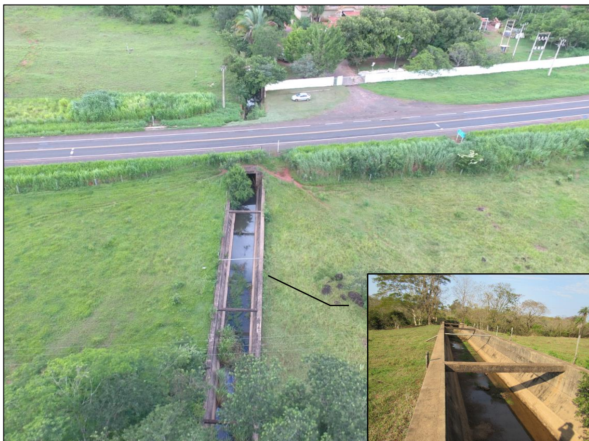
Figura 2.1: Estruturas existentes do antigo cala adutor.
