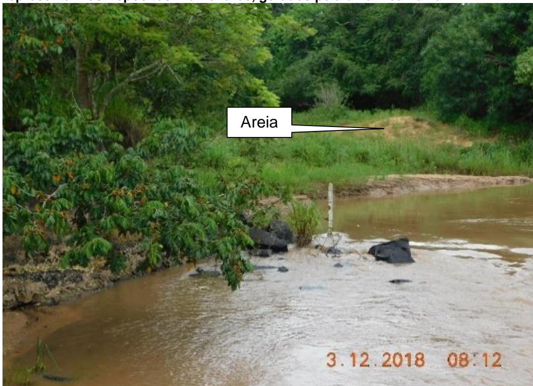
Figura 9.3: Depósitos de areia existentes na margem direita do rio Santana.
