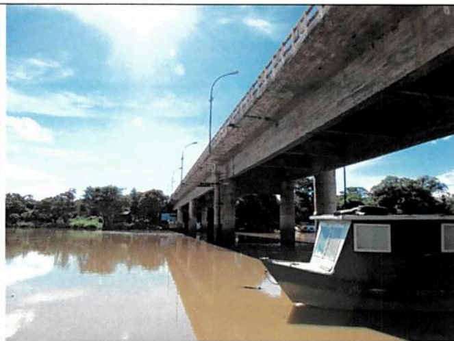
Figura 1: Pilar da ponte da MS-339 totalmente desobstruída.
