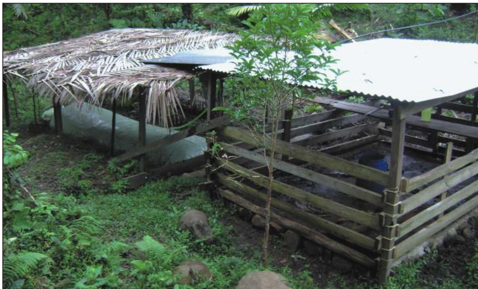
Figura 13 - Curral de confinamento noturno na Reserva Indígena Nairi Awari no Caribe da Costa Rica, com um biodigestor que produz biogás a partir das fezes dos porcos fechados durante as noites. Os ataques de felinos diminuíram, o biogás eliminou a necessidade de coletar lenha compensando o esforço de recolher os animais durante a noite e os indígenas sofreram uma menor exposição à fumaça nociva das cozinhas com fogão a lenha (Foto: R. Salom-Pérez, Programa Panthera Costa Rica).
