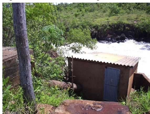
Figura 5.1.3.3.10 – Pequena casa de força junto à cachoeira Vista Alegre.
