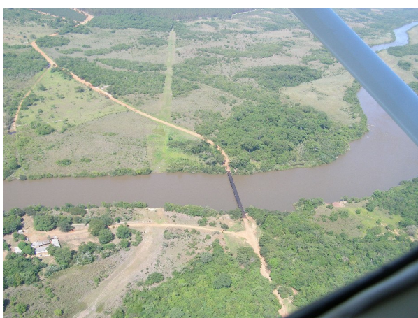
Figura 5.1.4.3.10 – Baixo rio Verde, em trecho livre de barragens e com poucas corredeiras
