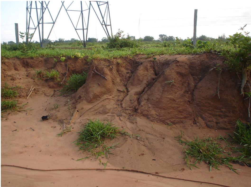
Figura 5.2.2.1.2 – Ravinamento observado em corte da estrada (desprovido de cobertura vegetal).
