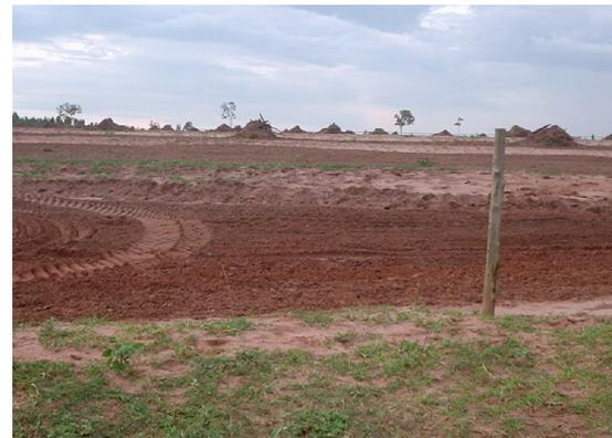
Figura 5.2.5.5.8 – Solo totalmente desprotegido e vulnerável aos processos erosivos.
