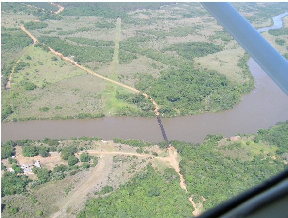
Figura 7.2.3.1.1 – Ponte muito utilizada para acesso ao reflorestamento que fica na área afetada pelo reservatório da UH Baixo Verde (20°53'11" S 52°21'33" O)
