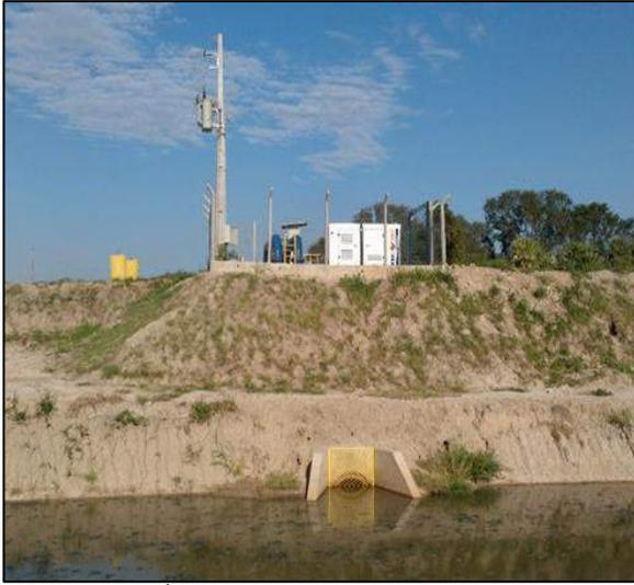
**Foto 3.23 – Águas pluviais acumuladas na caixa e o sistema de elevação ao fundo.**
