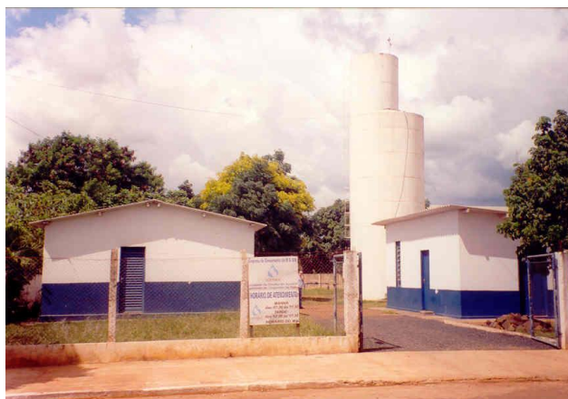
Figura 4 - Sanesul - poço e reservatório
