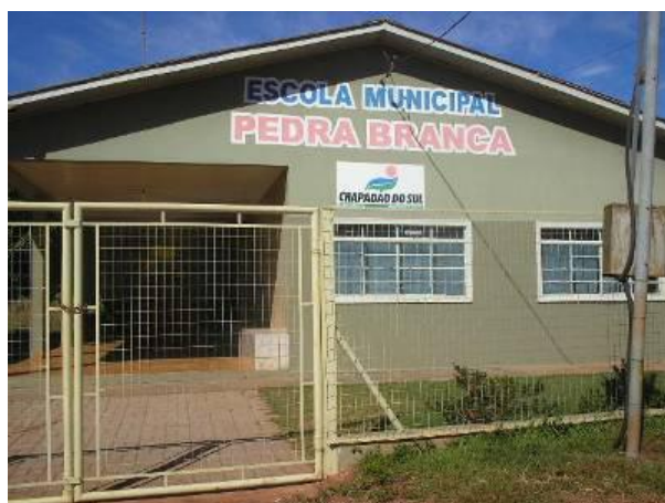
Figura 6 - Vista da Escola Municipal Pedra Branca
