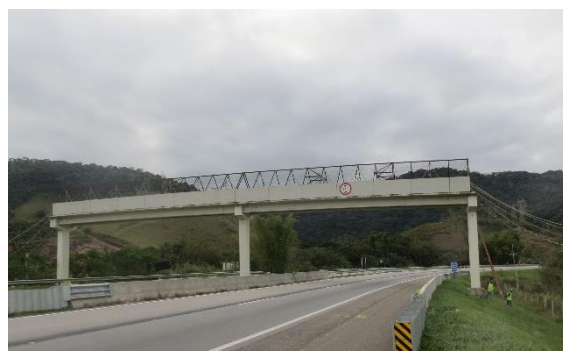
Figura 31. Passagem superior de fauna com múltiplas cordas ligadas às árvores da vegetação do entorno na BR-101/RJ. Foto: Helio Secco.
