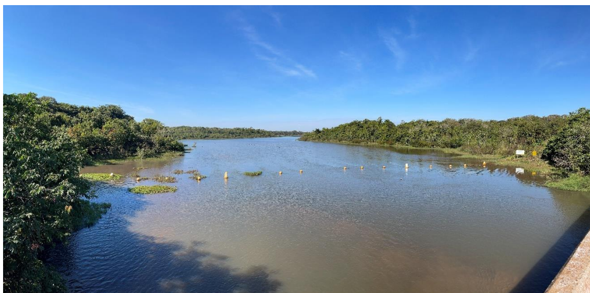
Figura 28. Boias de sinalização implantadas na Zona de Segurança do Reservatório (ZSR) PCH Paraíso, Município de Paraíso das Águas, MS.
