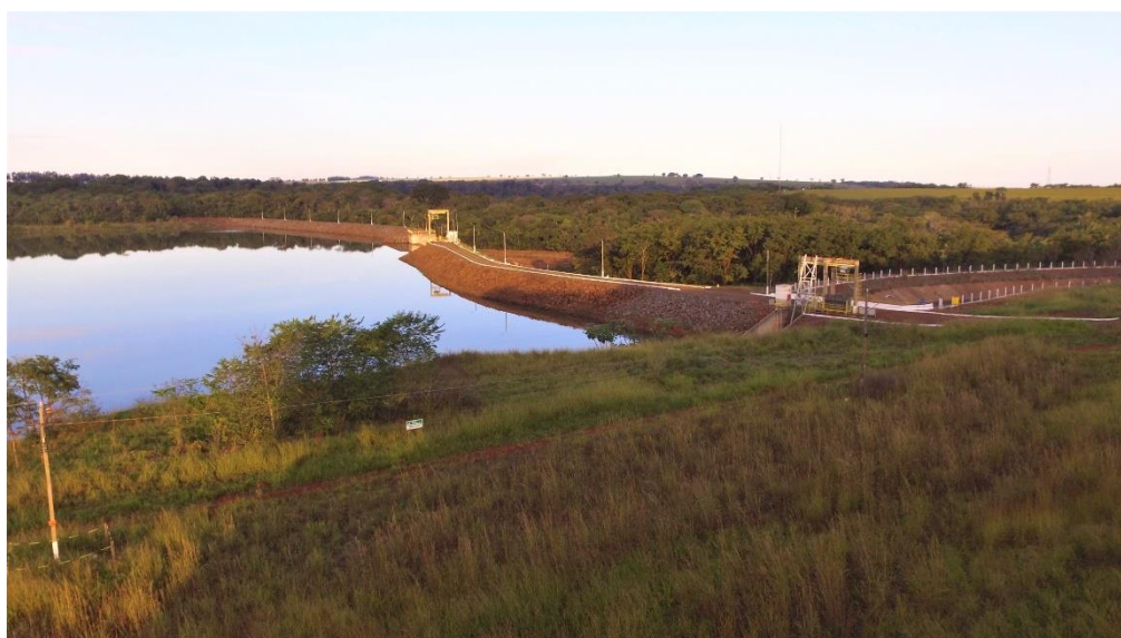
Figura 33. Barragem da PCH Paraíso, Município de Paraíso das Águas, MS.
