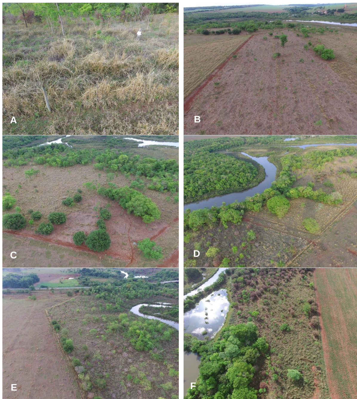
Figura 24. Vista aérea das áreas de restauração na Área de Preservação Permanente da PCH Paraíso I, Paraíso das Águas, MS. Outubro de 2021. A) Área 1; B) Área 3; C) Área 4.1; D) Área 4.2; E) Área 4.3; F) Área 13.
