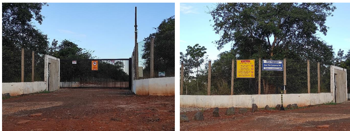
Figura 35. Portão de acesso da PCH Paraíso e sinalização de segurança implantada, Município de Paraíso das Águas, MS.
