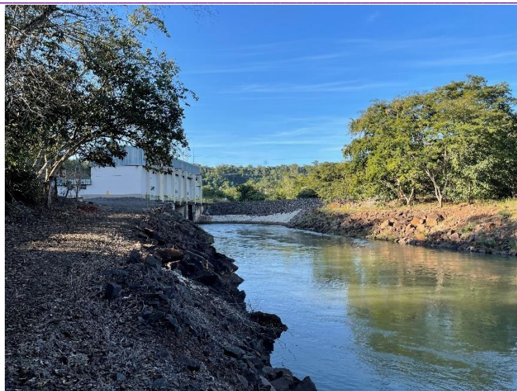
Figura 34. Zona de Segurança da Usina a jusante da Casa de Força da PCH Paraíso e sinalização de segurança implantada, Município de Paraíso das Águas, MS.
