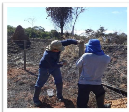
Foto 2.9-9: Manutenção de cercas
