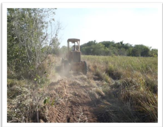
Foto 2.9-8: Manutenção de estradas internas
