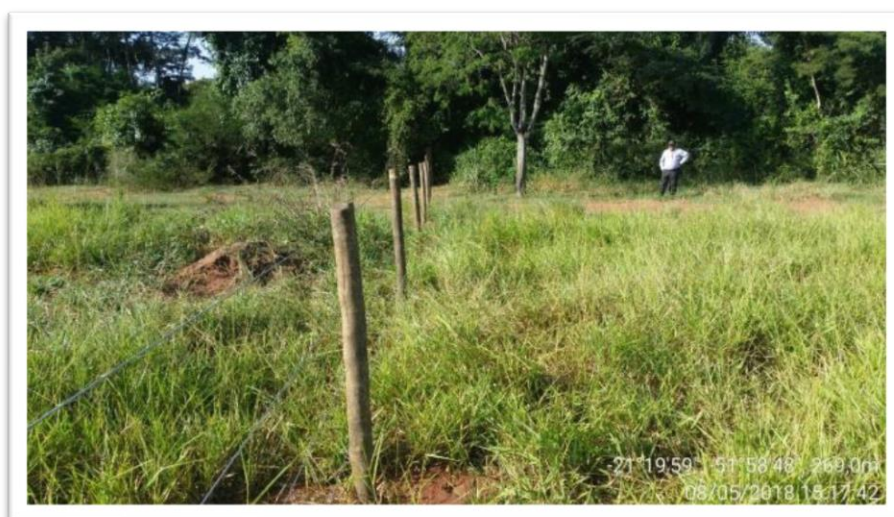
Fotos 2.9-1: Construção de cercas (divisa)
