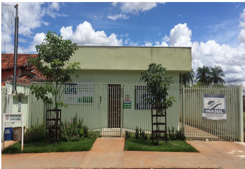
Figura 40. Vista principal do IMASUL.
