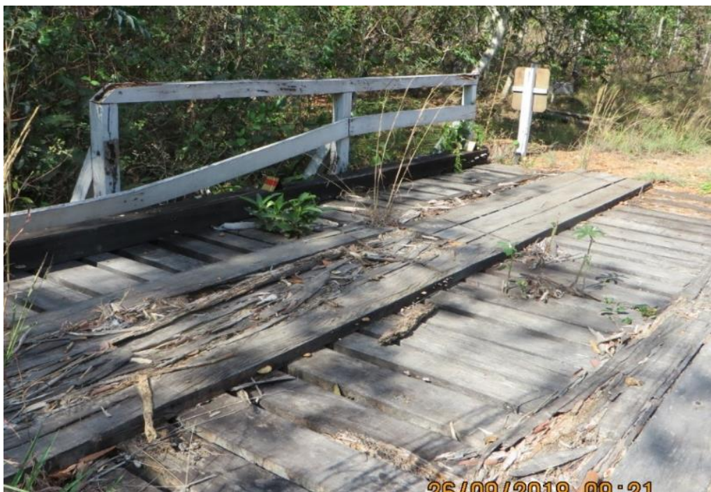
Figura 42. Ponte sobre o córrego Grota Fria, Costa Rica – MS.
