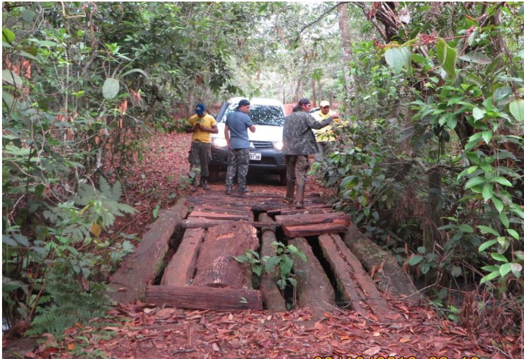
Figura 43. Ponte sobre o Ribeirão Furnas, Costa Rica – MS.
