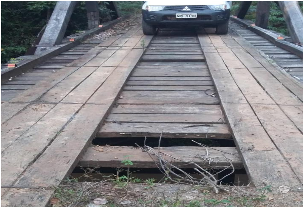
Figura 44. Ponte sobre o Ribeirão Engano, Alcinópolis – MS.
