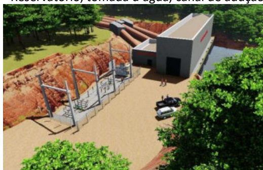
Casa de força e subestação
