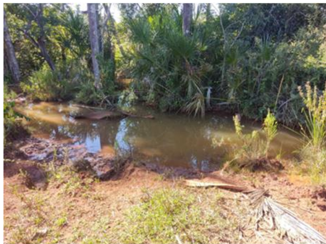
Córrego com drenagem restrita
