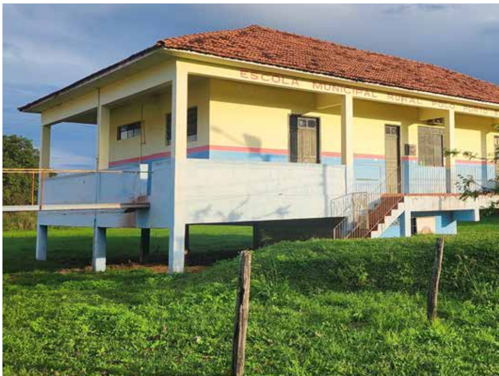
Escola Municipal em Porto Esperança. Fonte: Acervo Amplo Engenharia
